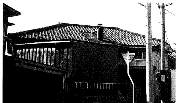
松高の旧図書館を解体して建てた製材場
