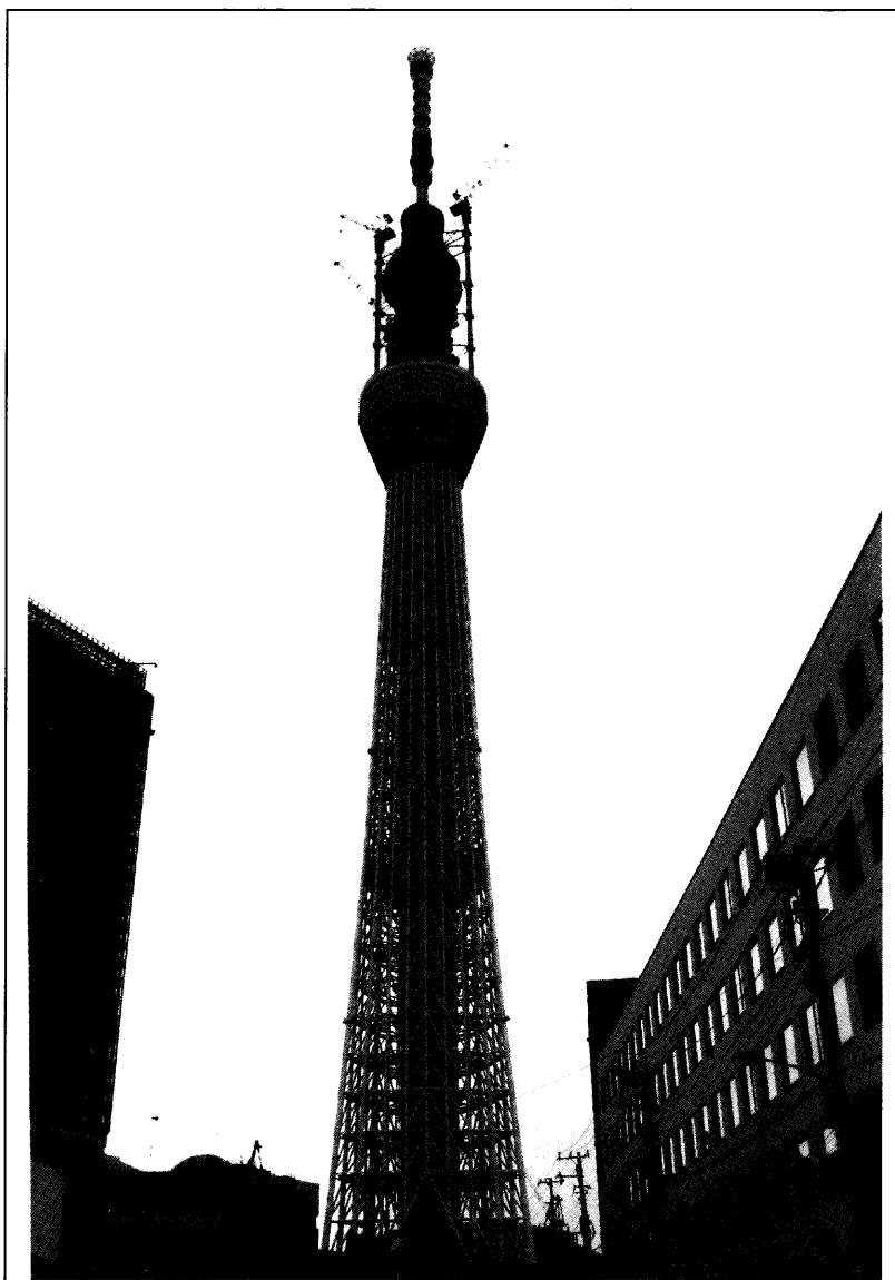
建設中の東京スカイツリーが3月18日、最終の高さ634(ムサシ)に到達。 先人の知恵も取り入れた塔は、今回の地震にビクともしなかった。
