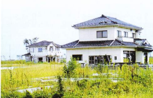
宮城県名取市閑上地区で未だに放置されたままの住宅
