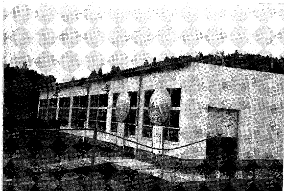
新設された雨天練習場
